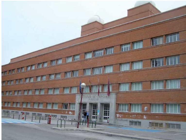
Fachada de la Facultad de Ciencias Físicas, antigua Facultad de Ciencias Físicas Matemáticas
