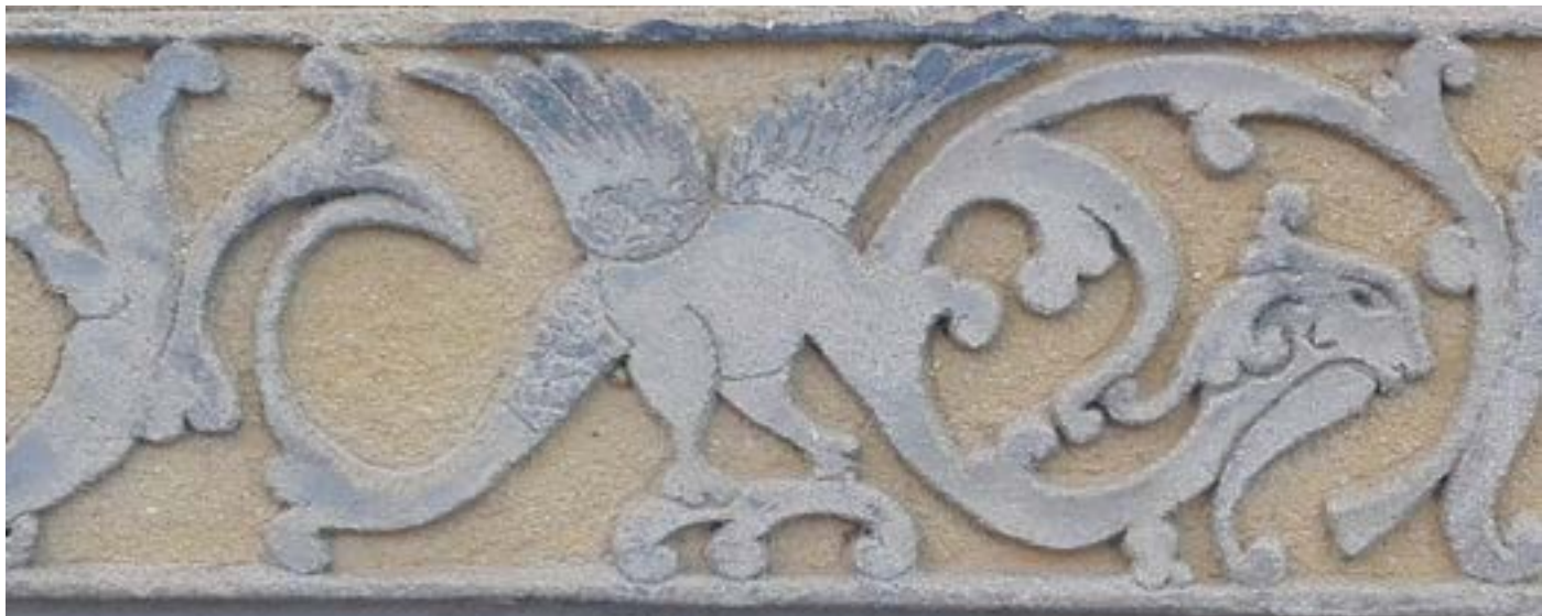
Arriba y abajo, detalles del esgrafiado de la fachada
